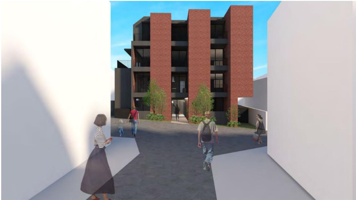
周辺に立ち並ぶ戸建て住宅群のデザインとボリューム感から逸脱しないように、ファサードを煉瓦タイルとし、三つの塔状で仕上げました。三本の煉瓦塔で形成することでバルコニーに陰影を生み、道路側住戸のプライバシーも守っています。
