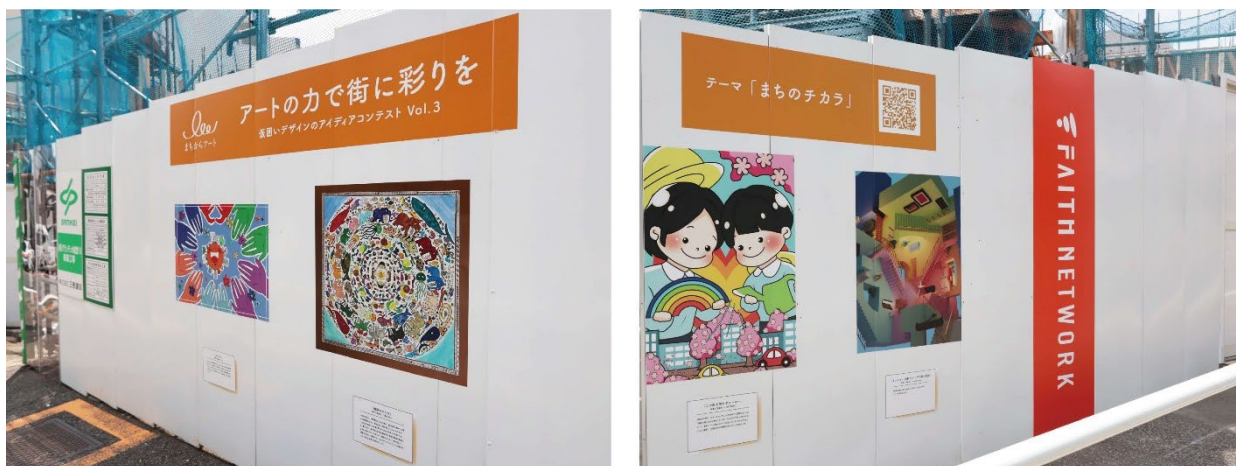
【作品展示を行う当社の物件建設現場の仮囲いの様子】
