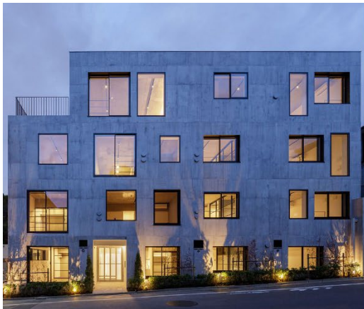
【外観から見た窓】
